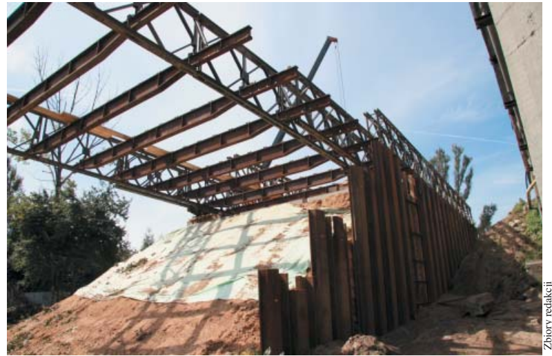
Budowa przeprawy tymczasowej na Kobiałce
